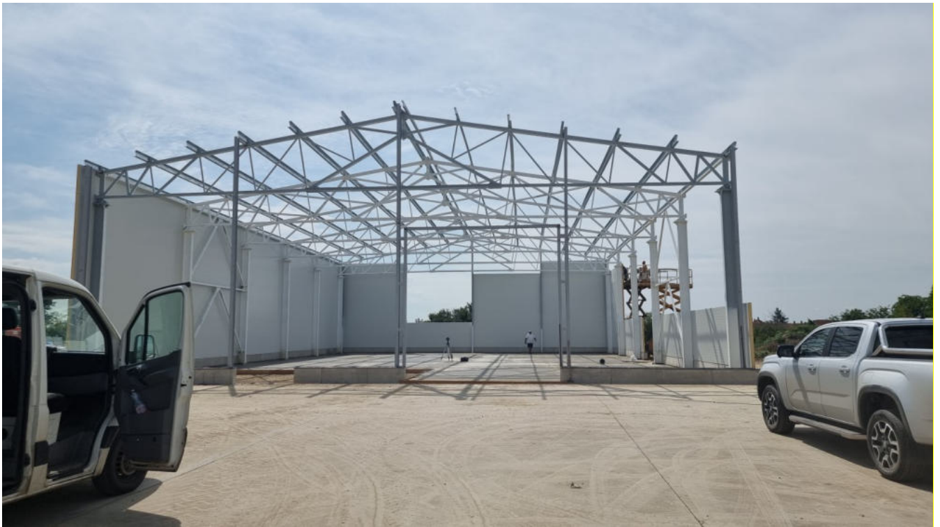
Hűtőház épület. Forrás: Saját fotó
